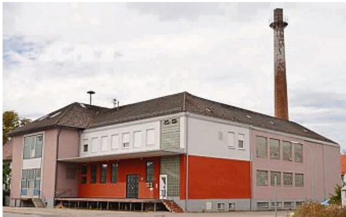
Das alte Molkerei-Gebäude soll abgerissen werden.
